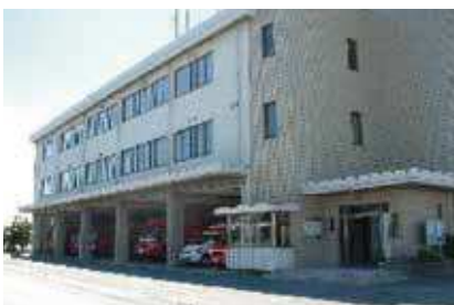
消防局・宇部中央消防署
