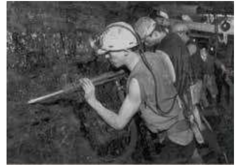
ビッグハンマーで削壁 (昭和30年)
