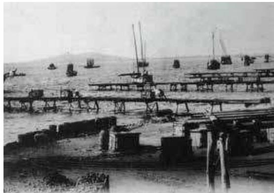
桟橋の先まで炭車を押していき、船の中に石炭
