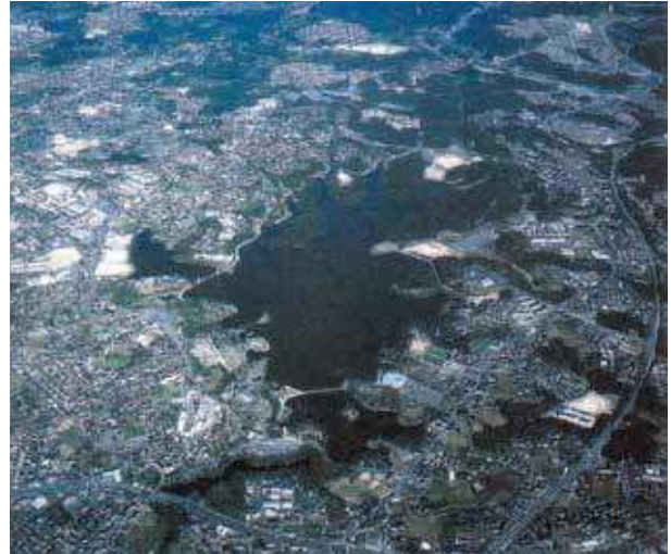
常盤池の全景
