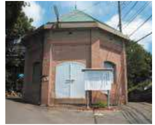
⑫ 宇部市の近代化を象徴する水道施設で六角堂と呼ばれて広く市民に親しまれている
