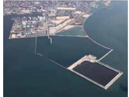
一般廃棄物最終処分場
