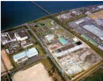
西部浄化センター
