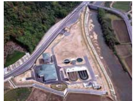
楠浄化センター
