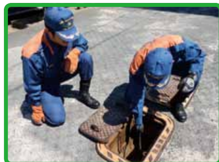
③ 消火栓の点検
