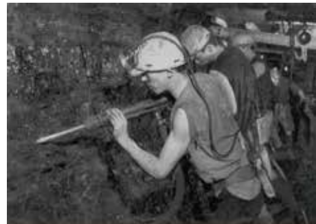
ビッグハンマーで削壁 (昭和30年)
