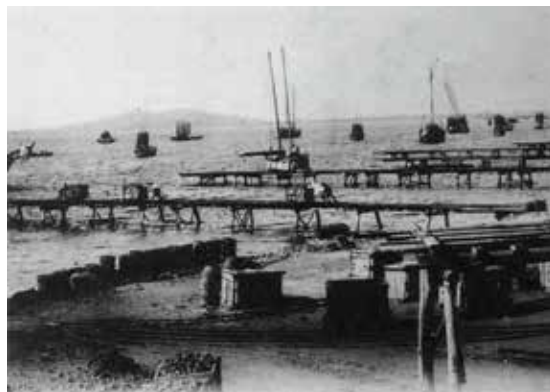
棧橋の先まで炭車を押していき、船の中に石炭 をひっくり返します。
