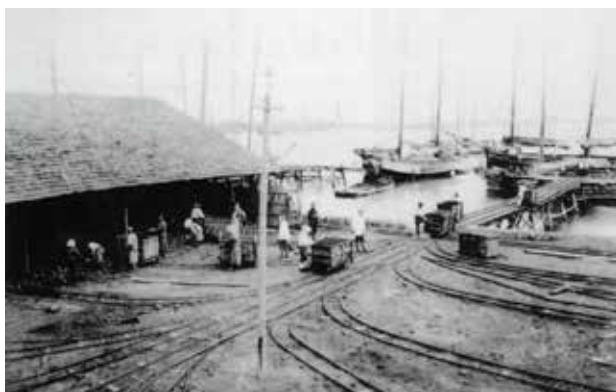
各地から石炭を運んできた炭車の線路が集まる 棧橋付近。
