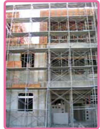
① 西岐波小学校校舎改築工事
