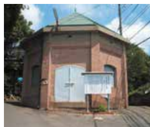
⑫宇部市の近代化を象徴する 水道施設で六角堂と呼ばれて 広く市民に親しまれている
