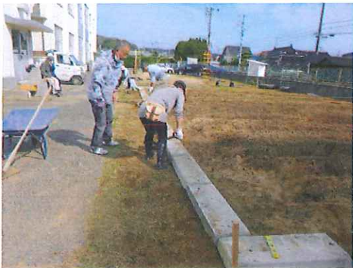
10/30 土留め石を設置
