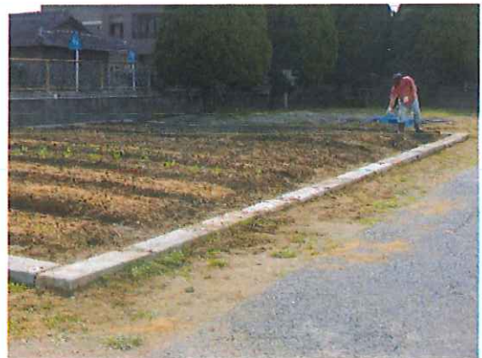
10/30 土留め石を設置
