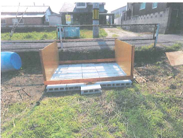
草捨て場の設営 (平成28年3月25日)
