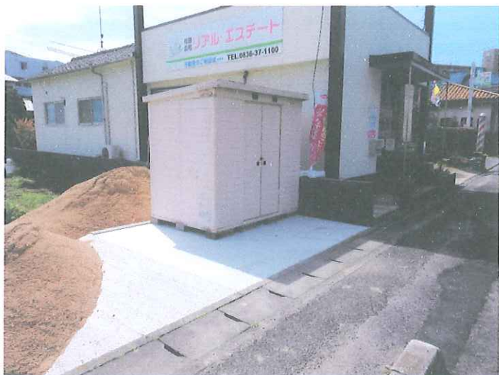
土の搬入と倉庫の立て付け (平成28年3月22日)
