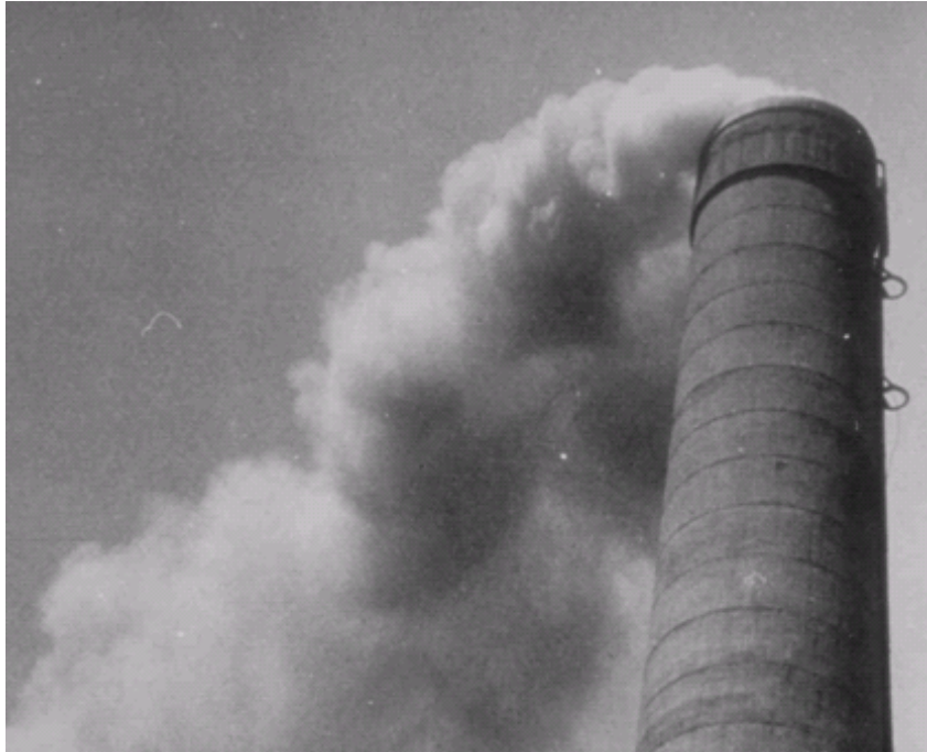
電気集じん装置運転休止中
