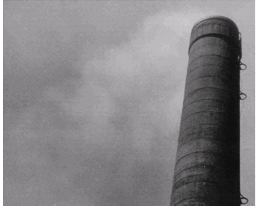
電気集じん装置運転中
