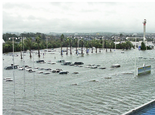
平成11年高潮被害（宇部空港）
