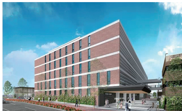
脱炭素技術を取り入れた新庁舎
