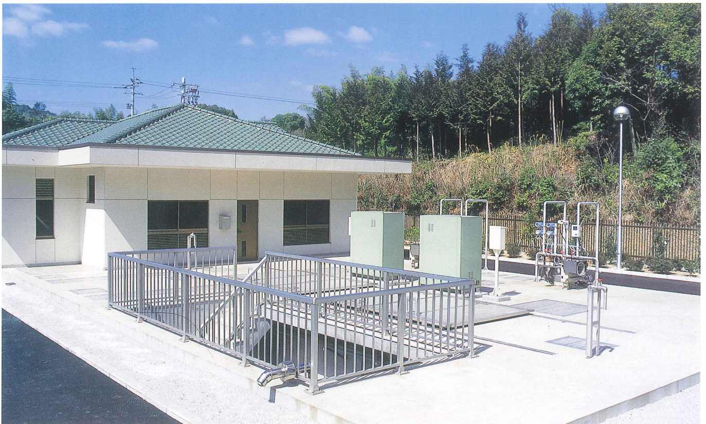
処理施設外観(回分槽)
