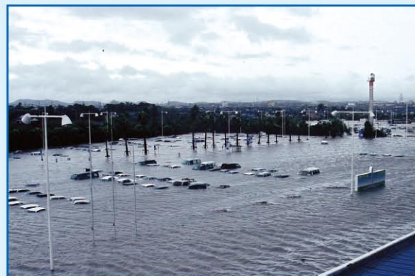
山口宇部空港の被害(平成11年台風第18号) 「山口県山口宇部空港事務所」
