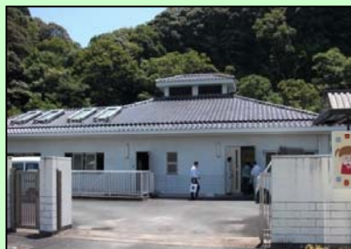
下小野地区クリーンセンターの建屋
