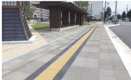
歩道舗装（インターロッキングブロック）
